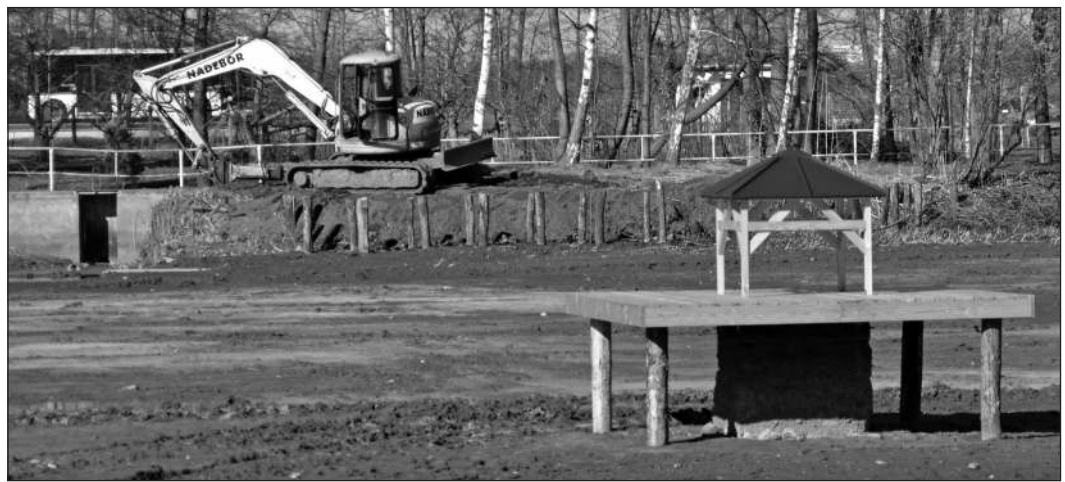
Stadtteichsanierung: Das ehemalige Fundament eines Leitungsmastes ziert inzwischen eine Plattform. Ob für Enten oder Angler müssen die Spaziergänger rausfinden. Im Hintergrund ist der Faschineneinbau zur Uferbefestigung zu sehen.
