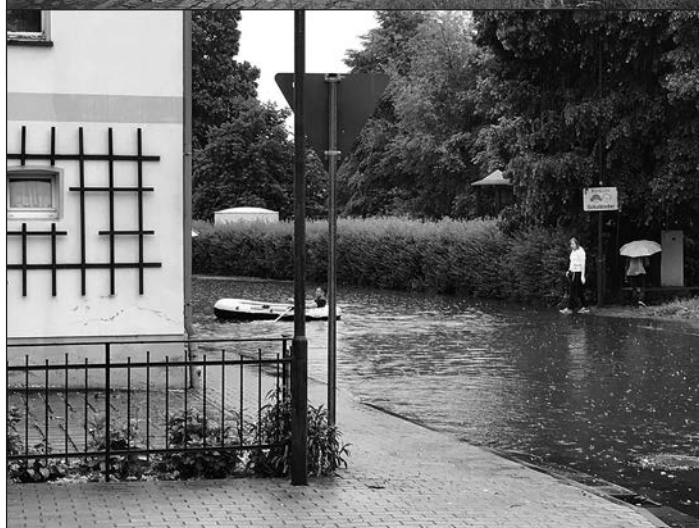
Baustelle Bebelstraße Der Zugang zur Kita war zeitweilig nicht möglich
